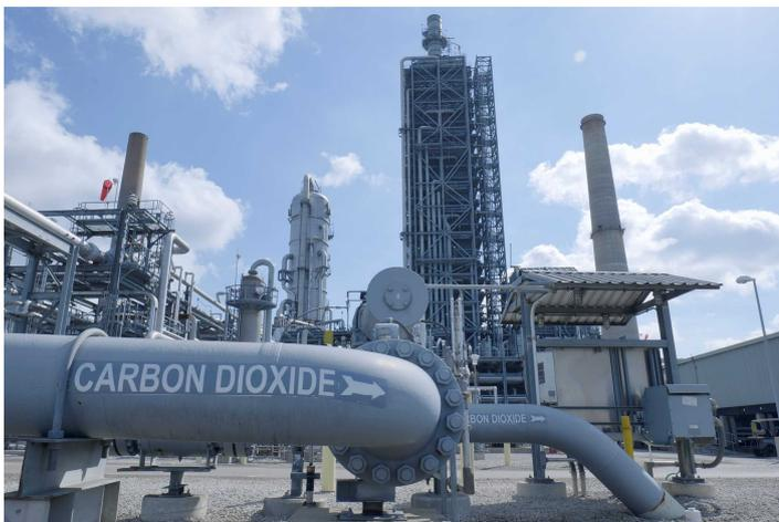
Petra Nova CCUSプロジェクトのCO<sub>2</sub>回収装置
