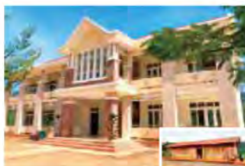
ベトナム：学校等の建設（ベトナム各地）
